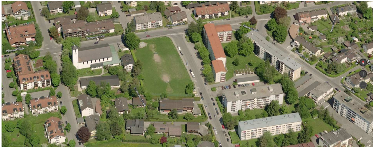
Bestandssituation des Plangebietes in der Bildmitte - Quelle: bing maps
